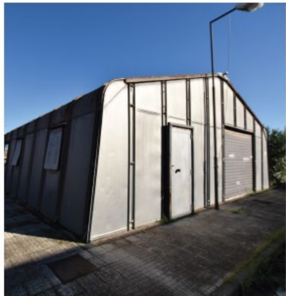
Capannone metallico "MORTEO"
